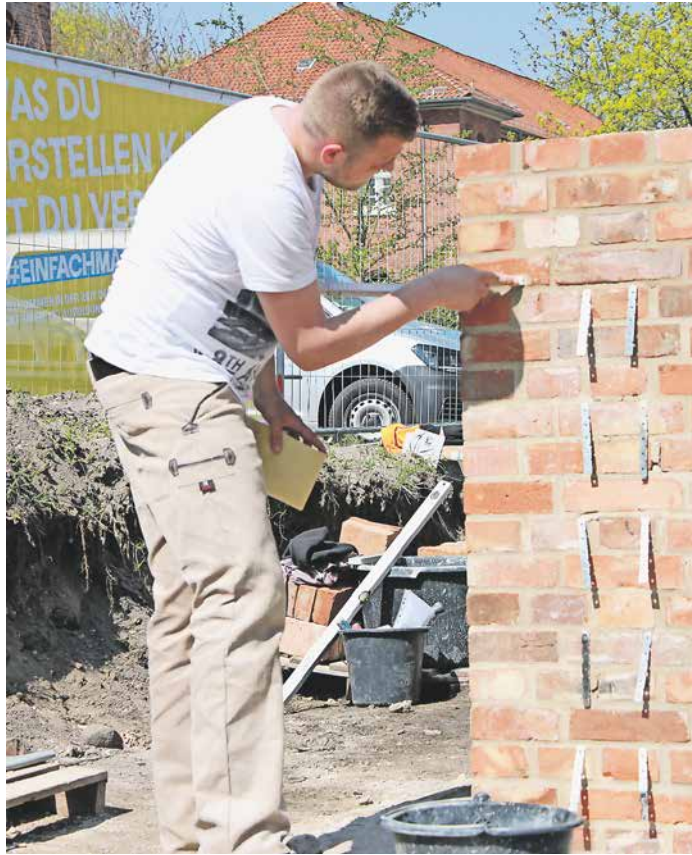
Maurerlehrlinge arbeiten während der ÜLU an der 73 Meter langen Mauer.
