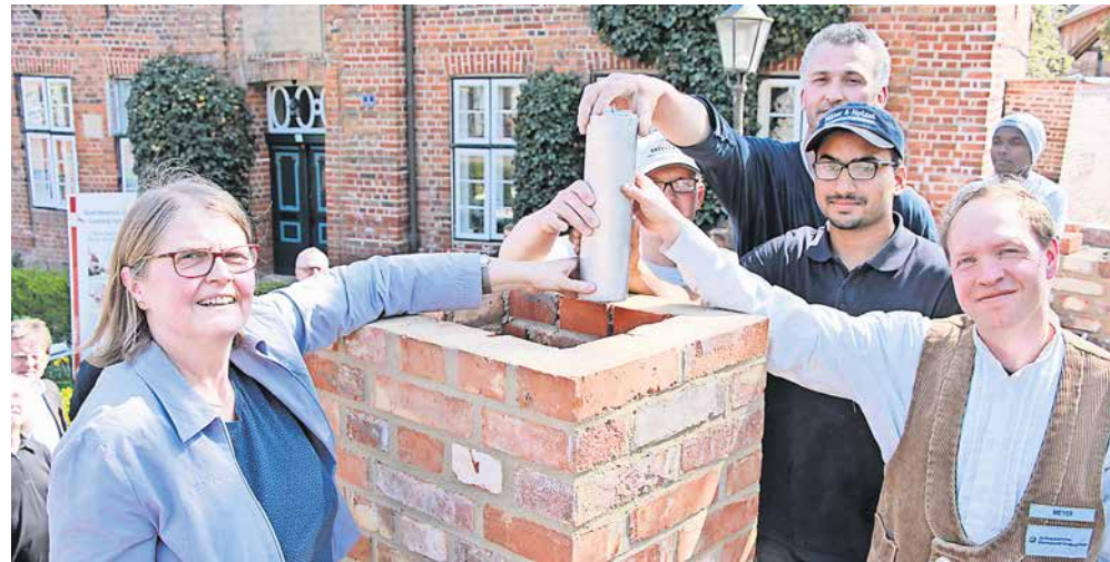
Grundsteinlegung: Dörthe Grimm (Lebensraum Diakonie e.V.) zusammen mit Jürgen Meyer (r.) und Lehrlingen.
