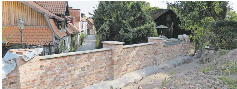
Die Maurerarbeiten sind fertig gestellt. Nur noch Kleinigkeiten fehlen zur Vollendung.
